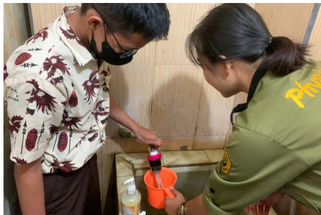
Gambar 3. Proses pemasangan filter air dan pengamatan kualitas air.
