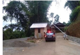
Gambar 11. Kondisi drainase jalan setelah dibenahi
