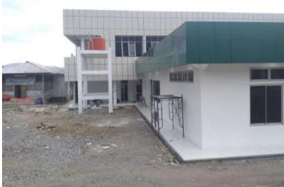
Gambar 8. Kondisi bangunan di wilayah Kabupaten Tolikara yang sudah menggunakan material pabrik seperti tembok, atap seng, keramik, cat dan aksesoris lainnya
