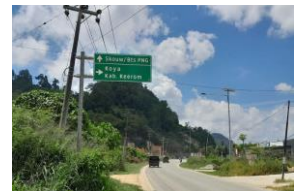
b. Jalan poros Holtekamp dengan permukaan beraspal
